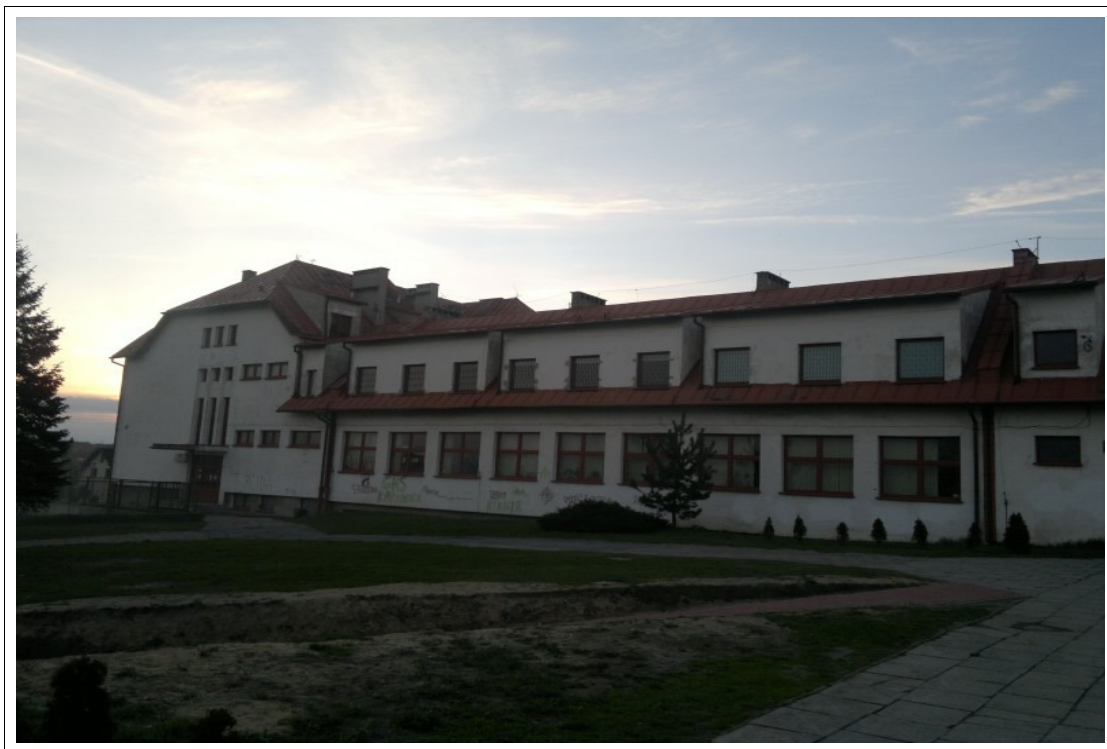
FOT 1-002. 04.06.2012 – Żernica ul. Leopolda Miki 37 - obiekt szkolno-przedszkolny - widok zachodniej części elewacji południowej budynku.
