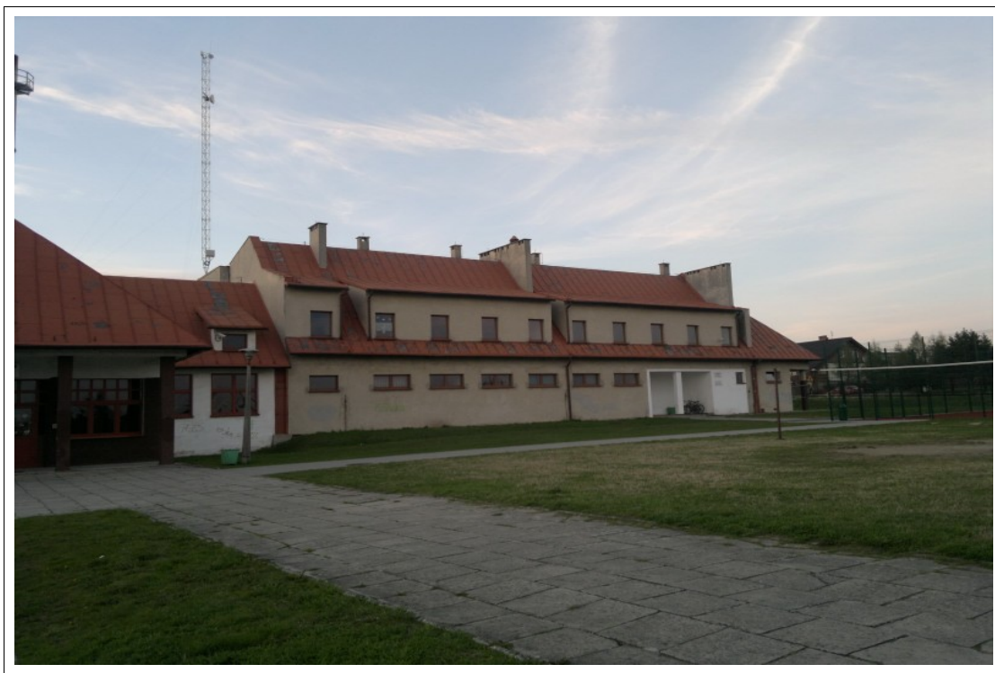
FOT 1-003. 04.06.2012 – Żernica ul. Leopolda Miki 37 - obiekt szkolno-przedszkolny - widok wschodniej części elewacji południowej budynku.
