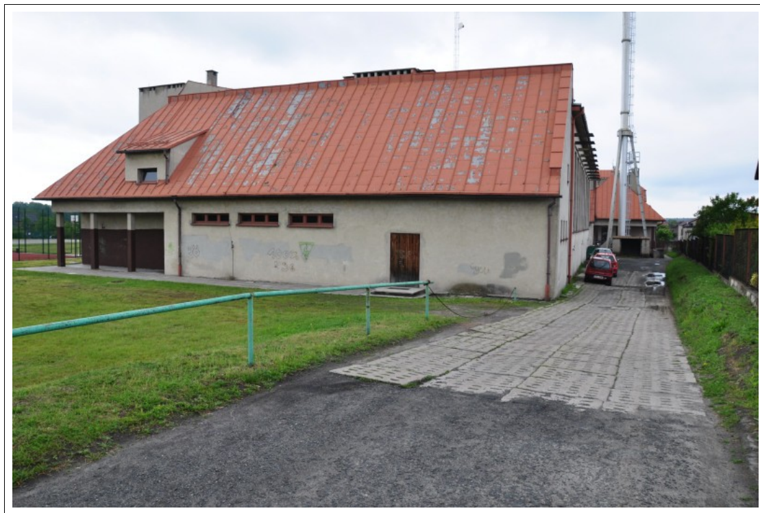
FOT 1-006. 04.06.2012 – Żernica ul. Leopolda Miki 37 - obiekt szkolno-przedszkolny - widok wschodniej elewacji budynku - w tle komin z kotłowni.
