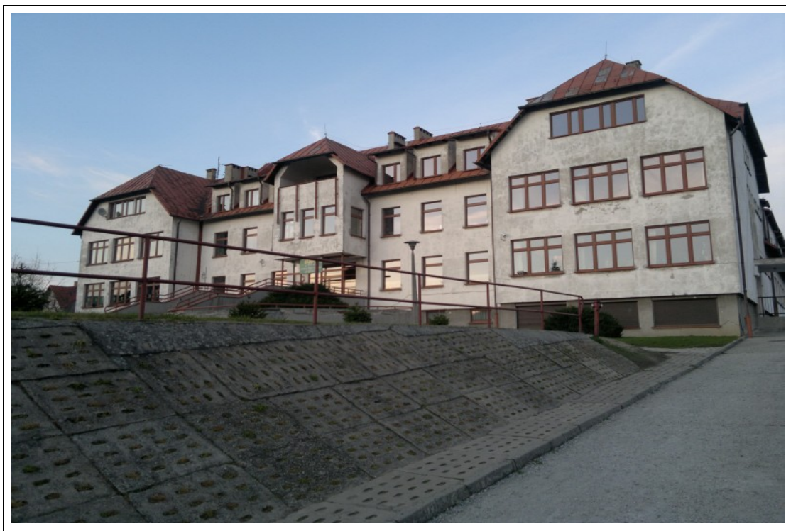
FOT 1-001. 04.06.2012 – Żernica ul. Leopolda Miki 37 - obiekt szkolno-przedszkolny - widok ogólny elewacji zachodniej.
