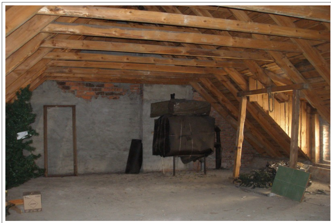
FOT 1-027. 04.06.2012 – Żernica ul. Leopolda Miki 37 - obiekt szkolno-przedszkolny - widok ogólny więźby dachowej segmentu G.
