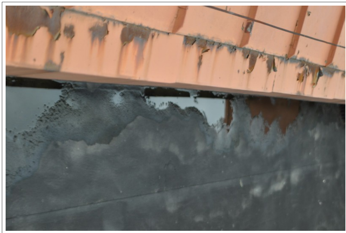
FOT 1-024. 04.06.2012 – Żernica ul. Leopolda Miki 37 - obiekt szkolno-przedszkolny - j.w.
