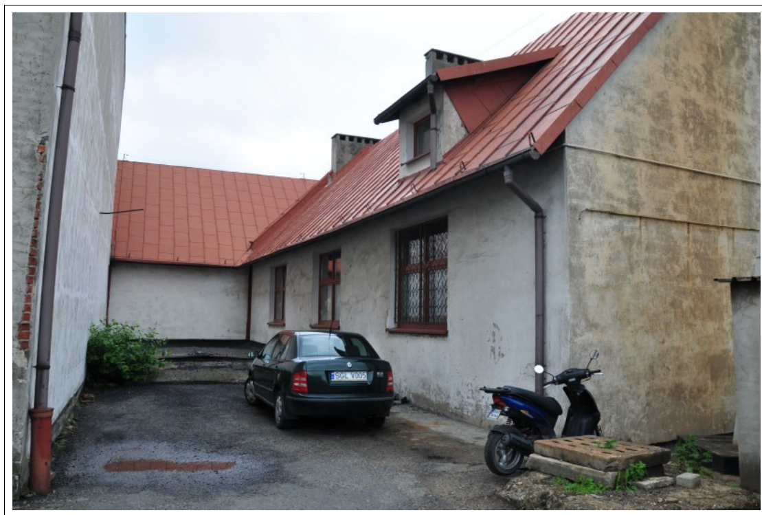
FOT 1-007. 04.06.2012 – Żernica ul. Leopolda Miki 37 - obiekt szkolno-przedszkolny - widok elewacji segmentu G, I - dojazd do zsypu opału.
